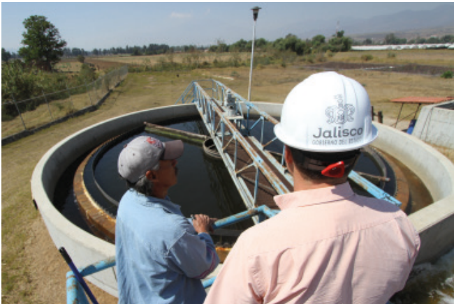
La disposición final de los residuos y las aguas residuales generan gases y compuestos de efecto invernadero. Planta de tratamiento de aguas residuales de Gómez Farías.
